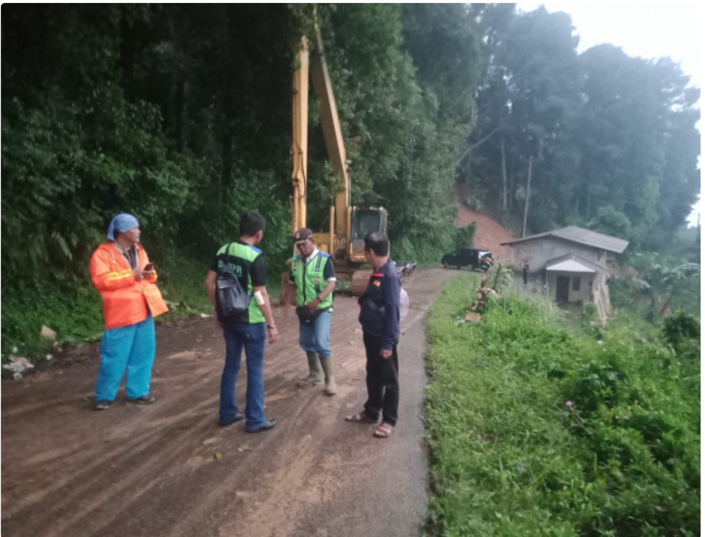
Tim UPT Insfratraktur Jalan Dan Jembatan Wilayah Leuwiliang saat melakukan evakuasi jalan.
